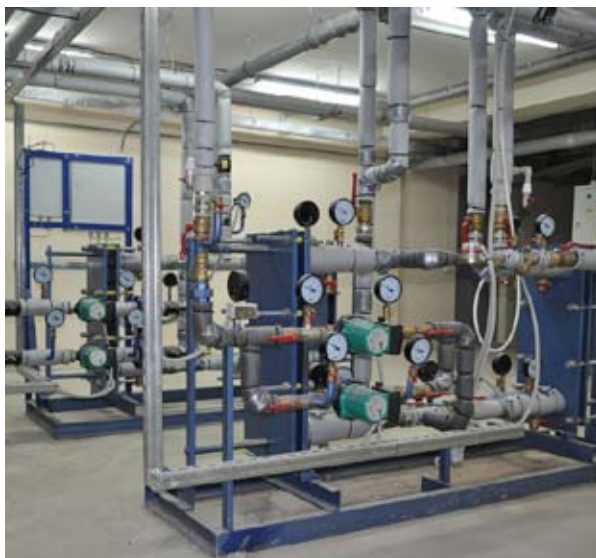
■ Рис. 1. ИТП на базе пластинчатого теплообменника
