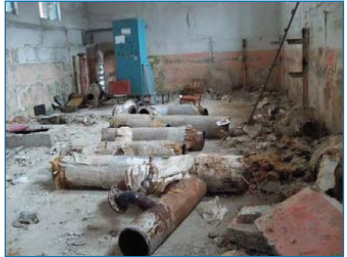
Рисунок 1. Помещение бывшего ЦТП после демонтажа старого оборудования.
