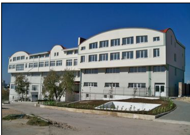
Рис. 1. Производственное здание, где осуществляется разработка и выпуск теплообменников ТТАИ, г. Севастополь.
